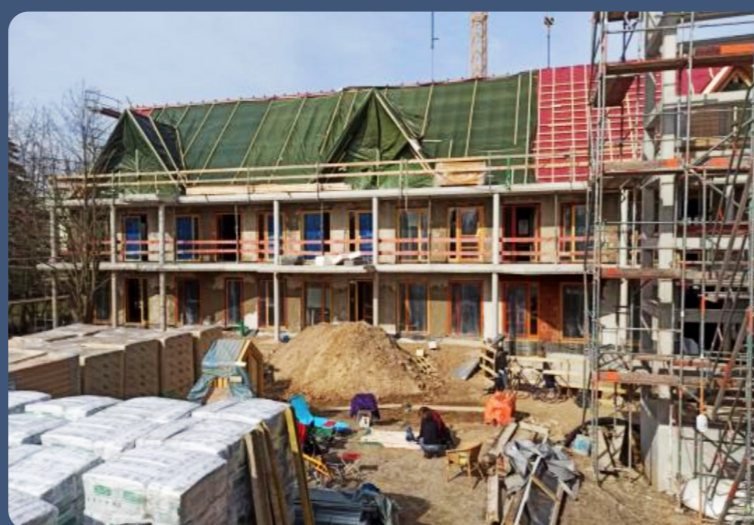
Bild: Baustelle der Wokubi eG in Biesenthal
