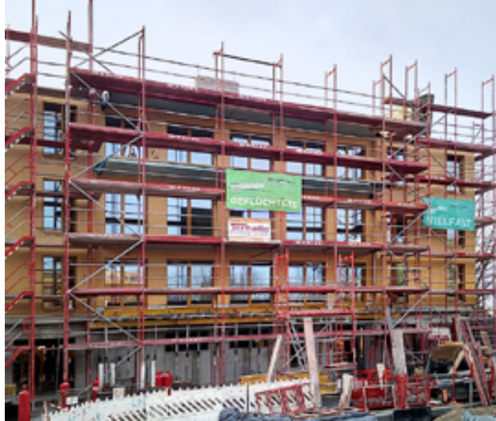
Baustelle Baugenossenschaft BeGeno16 eG
